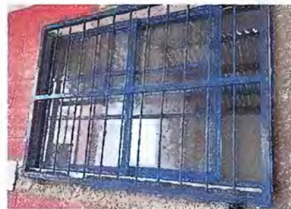
Foto 18: MÓDULO 2 Sustitución de vidrios
