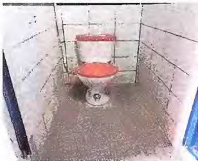
Foto 1: MODULO 1. Sustitución de inodoros en mal estado
