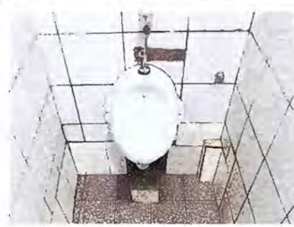
Foto 2: MODULO 1. Sustitución Mingitorio en mal estado
