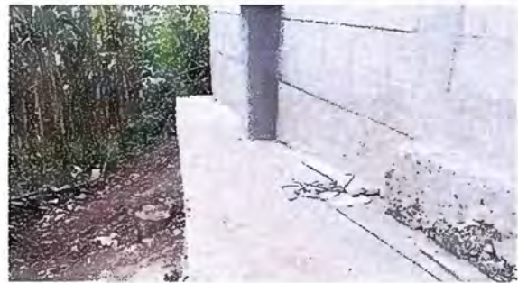
Foto 16: MÓDULO 2 Reparacion de banqueta de concreto
