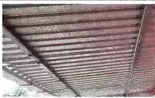
Foto 10: MÓDULO 2 Sustrucción de estructura de soporte de madera por metal en estado
