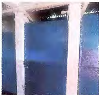
Foto 7: MÓDULO 1 Sustrucción de puertas en mal estado
