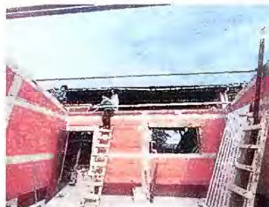
Foto 10: MÓDULO 2 Sustrucción de estructura de soporte de madera por metal en estado
