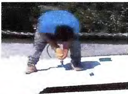
Foto 9: MÓDULO 2 Sustrucción de fijación tornillos punta de broca
