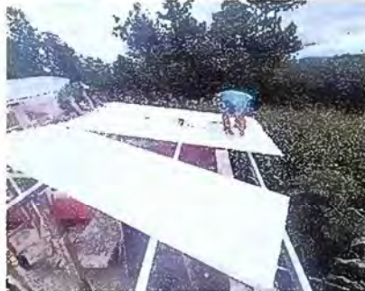
Foto 8: MÓDULO 2 Sustrucción de lámina en mal estado
