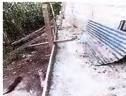
Foto 16: MÓDULO 2 Reparacion de banqueta de concreto
