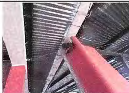
Foto 20: MÓDULO 3 - Corredor. Sustitución bajada de agua pluvial por tubo PVC
