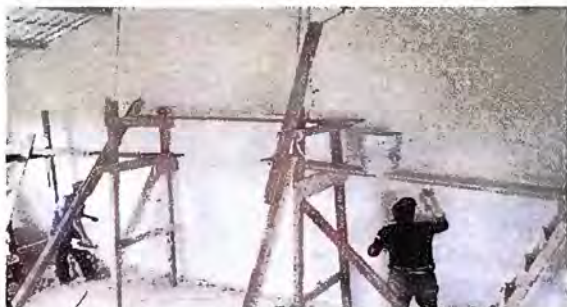
Foto 15: MÓDULO 2 Repello en muro
