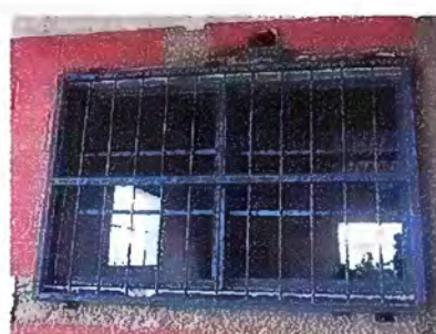
Foto 18: MÓDULO 2 Sustitución de vidrios
