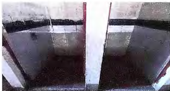
Foto 7: MÓDULO 1 Sustrucción de puertas en mal estado
