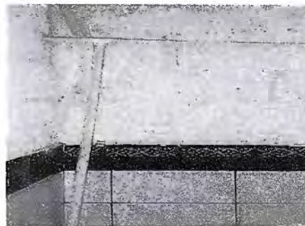
Foto 6: MODULO 1 Sustitución tubería de agua línea agua
