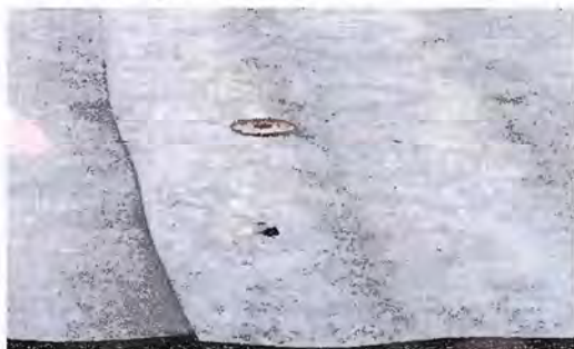
Foto 9: MÓDULO 2 Sustitución de fijación tornillos punta de broca
