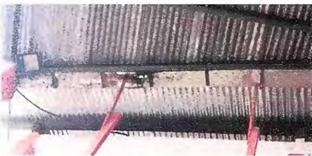
Foto 21: MÓDULO 3 Sustitución de canal de metal, por canal PVC
