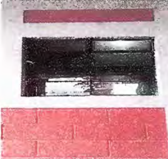
Foto 18: MÓDULO 2 Sustitución de vidrios
