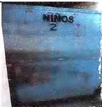
Foto 7: MÓDULO 1 Sustitución de puertas en mal estado
