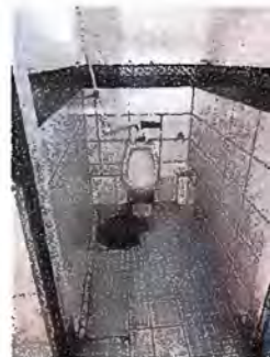
Foto 2: MODULO 1 . Sustitución Mingitorio en mal estado
