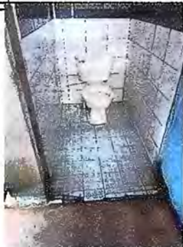
Foto1: MODULO 1 . Sustitución de inodoros en mal estado
