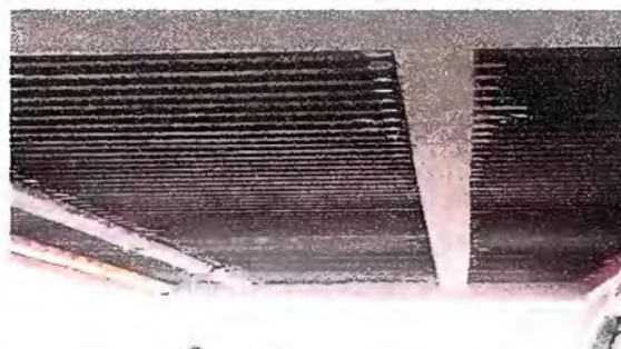
Foto 10: MÓDULO 2 Sustitución de estructura de soporte de madera por metal en estado
