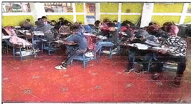
Foto 6: colocación de piso ceramico aula 3, proyecto de remozamiento finalizado el 100%.
