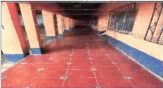
Foto1: colocación de piso ceramico en el corredor finalizado, modulo 1
