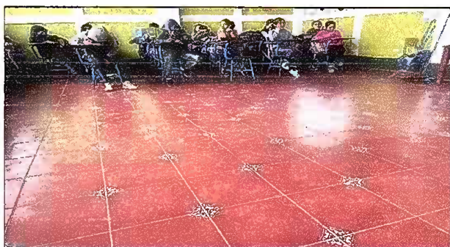
Foto 4: colocación de piso ceramico aula 1 terminado, modulo 4
