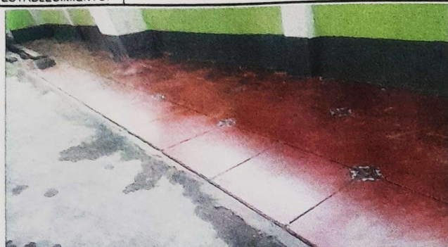
Foto 1: colocación de piso en proceso.
