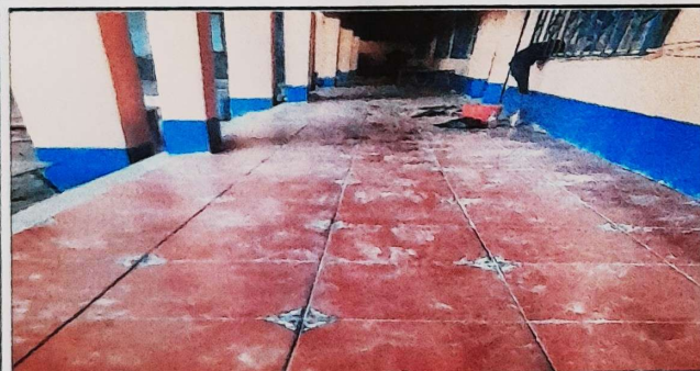
Foto 3: Colocación de piso en el corredor de las aulas.
