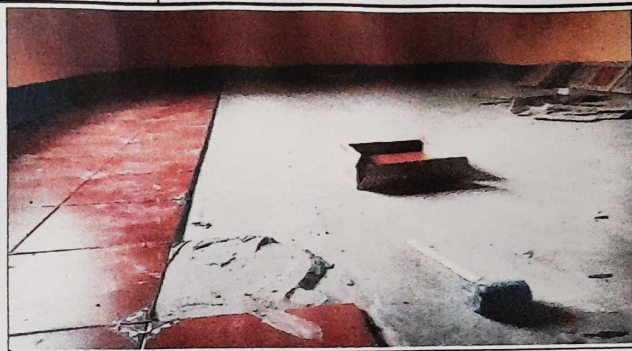
Foto 2: Colocación de piso en las aulas .
