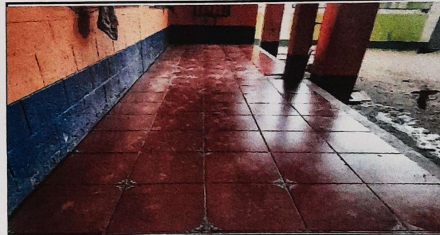
Foto 4: piso cermámico terminado en el primer módulo.
