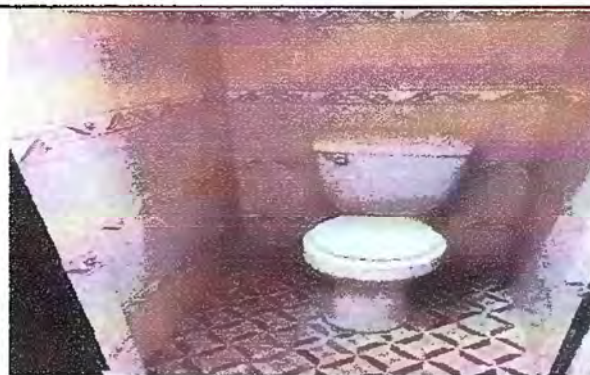
Foto 4: Sustitución de inodoro
