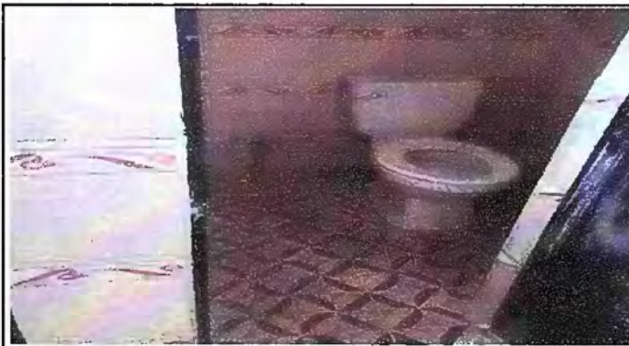
Foto 8: Sustitución de accesorios
