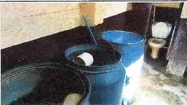
Foto 3. Módulo 1, Sustrucción de azulejo.
