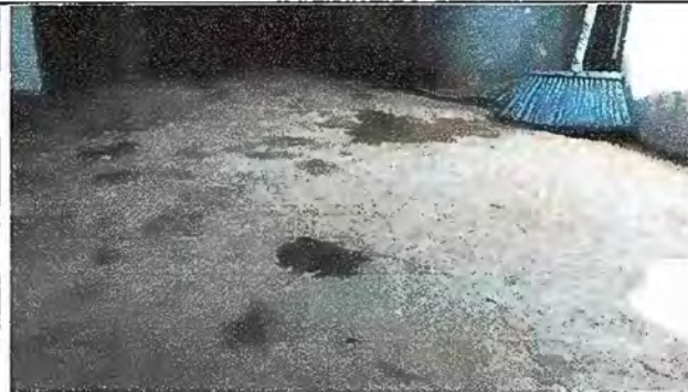
Foto 2. Módulo 1, Sustrucción de piso de torta de concreto por piso cerámico antideslizante
