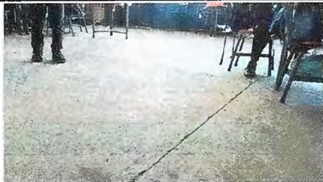
Foto 1. Módulo 1, Sustrucción de piso de torta de concreto por piso cerámico
