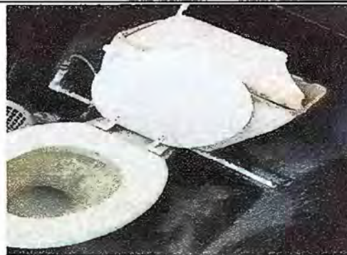
Foto 4. Módulo 1, Sustrucción de inodoro
