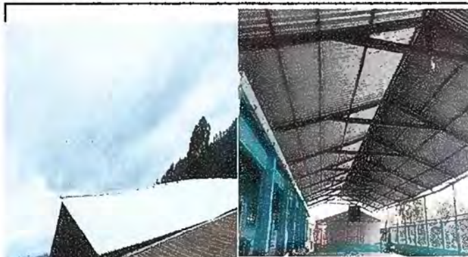
Foto 2: Sustitucion de laminas Troqueladas Aluzinc
