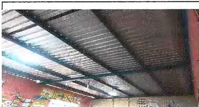
Foto1: MODULO 1 Sustitucion de laminas Troqueladas Aluzinc
