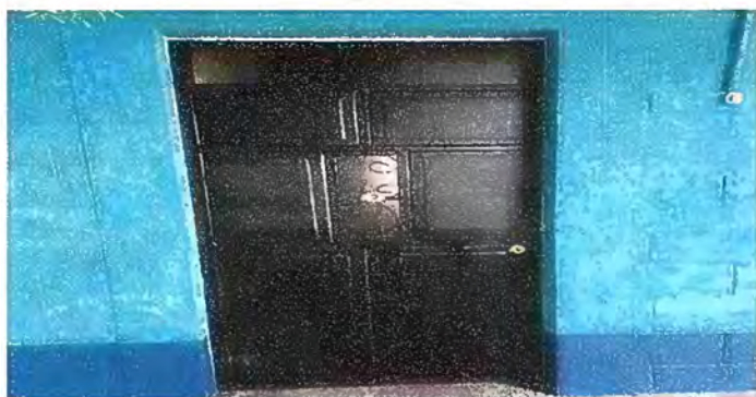
Foto 5: Modulo 1 Sustitución de puertas
