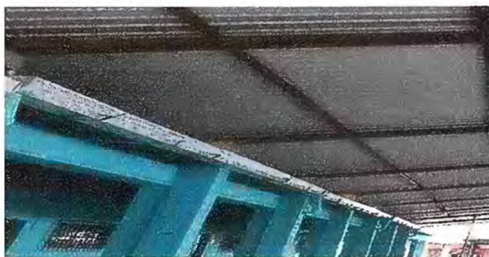
Foto 3: MODULO 1 sustitucion de canales de metal
