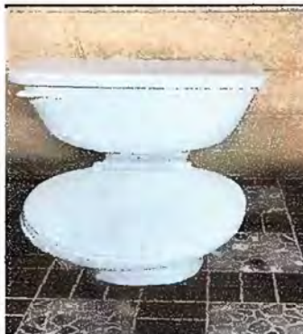
Foto 8. Módulo 3 Sustitucion de inodoro
