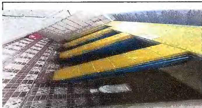
Foto7: MODULO 2 Sustitucion de piso
