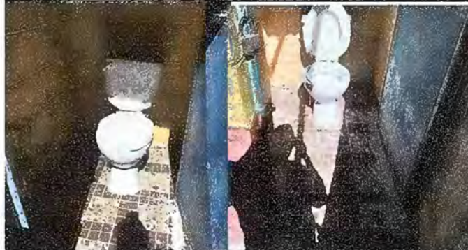
Foto 8. Módulo 3 Sustitucion de inodoro
