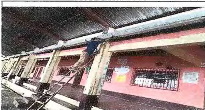
Foto 3: MODULO 1 sustitucion de canales de metal
