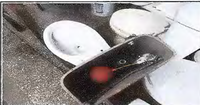
Foto 9: MODULO 3 sustitucion de accesorio de inodoro
