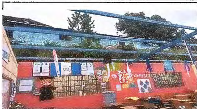
Foto 2: Sustitucion de laminas Troqueladas Aluzinc
