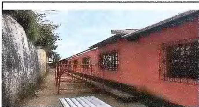
Foto1: MODULO 1 Sustitucion de laminas Troqueladas Aluzinc
