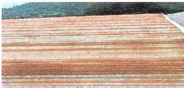
Foto1: MODULO 1 Sustitucion de laminas Troqueladas Aluzinc
