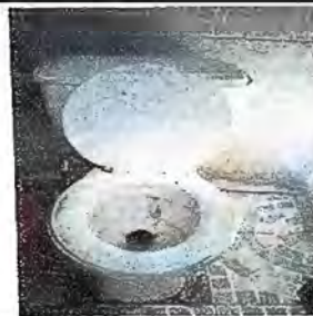
Foto 8. Módulo 3 Sustitucion de Inodoro
