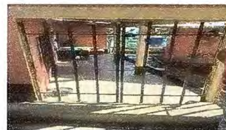
Foto 12: Módulo 6 sustitucion de puerta de doble hoja de metal tipo regilla
