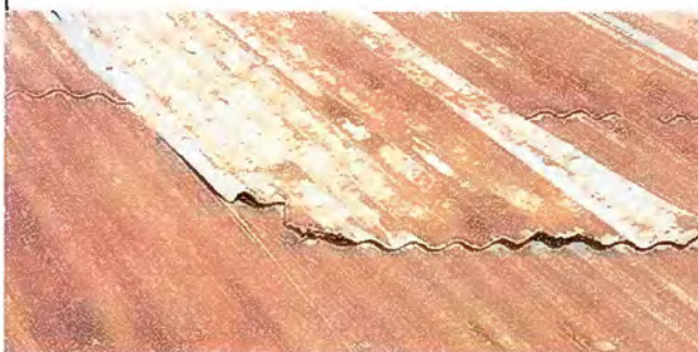
Foto 2 Sustitucion de laminas Troqueladas Aluzinc
