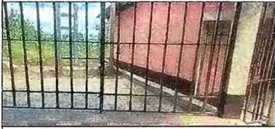
Foto13: MODULO 6 sustitucion de puertas de doble hoja de metal tipo regilla
