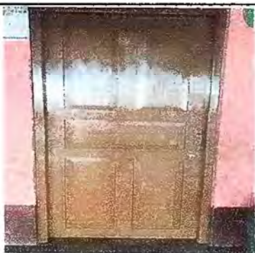
Foto 5: Modulo 1 Sustitución de puertas
