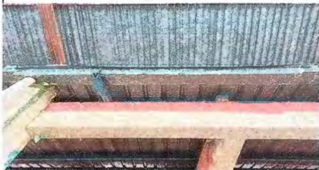
Foto 3: MODULO 1 sustitucion de canales de metal
