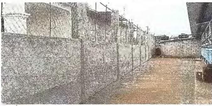
Foto 3: muro perimetral de block, con tubo HG, malla galvanizada, soleras intermedias y columnas.
