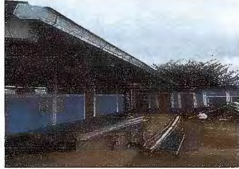
Foto 2: Sustrución de canal de metal
