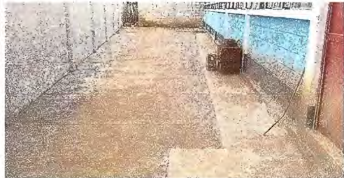
Foto 4: reparacion de plancha de concreto de patio.
