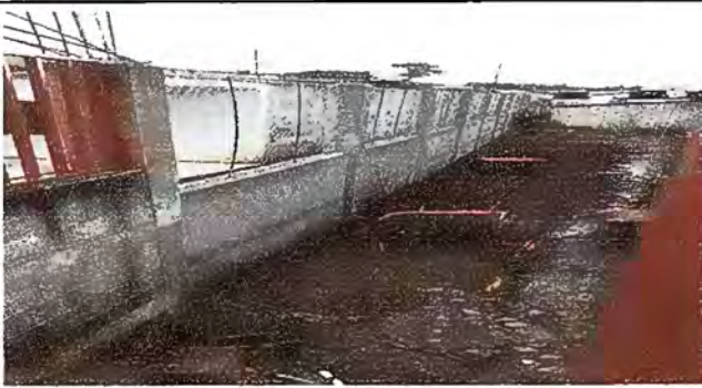
Foto 3: muro perimetral de block, con tubo HG, malla galvanizada, soleras intermedias y columnas.
