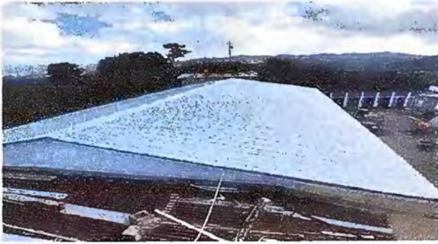
Foto1: Sustrución de lámina por lámina troquelada
