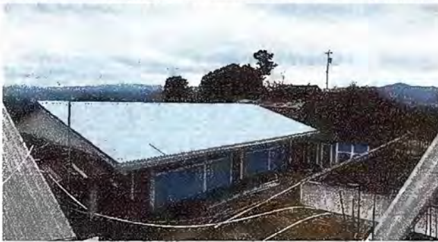
Foto 1: Sstitucion de lámina por lámina troquelada
