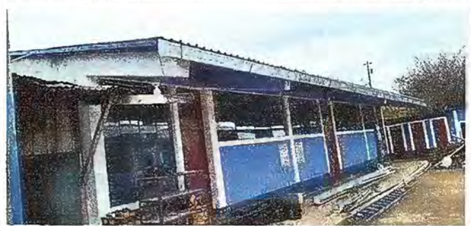
Foto 2: Sustitucion de canal de metal
