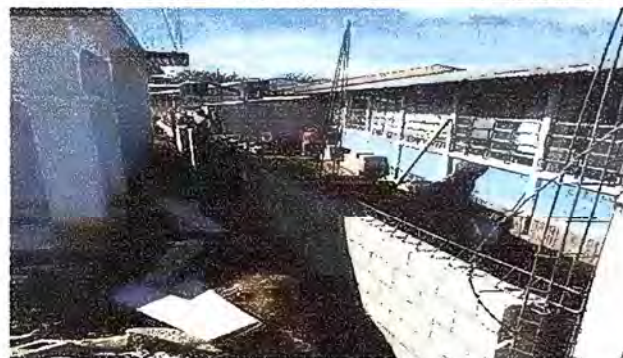
Foto 3: muro perimetral de block, con tubo HG, malla galvanizada, soleras intermedias y columnas.
