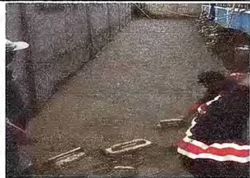
Foto 4: reparacion de plancha de concreto de patio.
