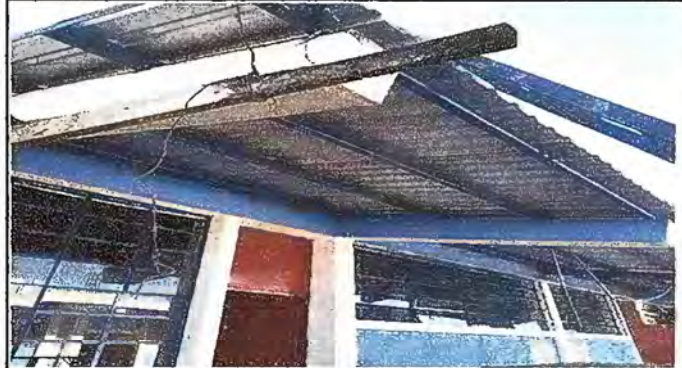
Foto 2: Sustrución de canal de metal
