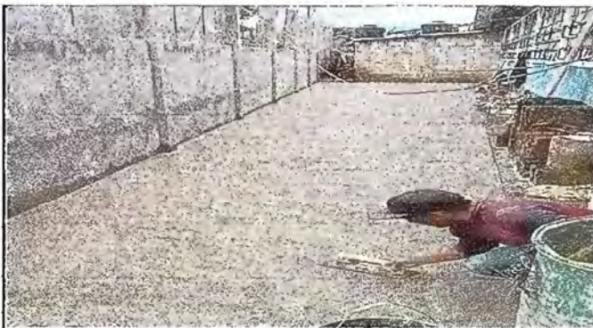
Foto 4: reparacion de plancha de concreto de patio.
