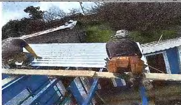
Foto1: Sistitucion de lámina por lámina troquelada
