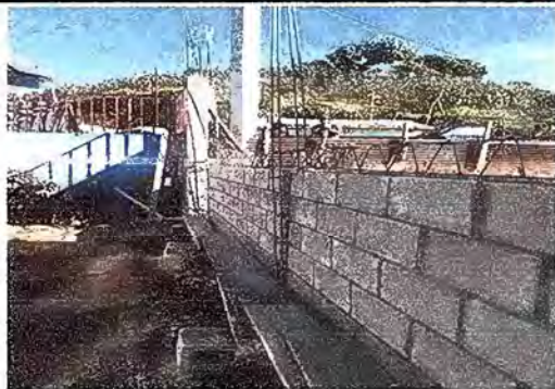
Foto 3: muro perimetral de block, con tubo HG, malla galvanizada, soleras intermedias y columnas.
