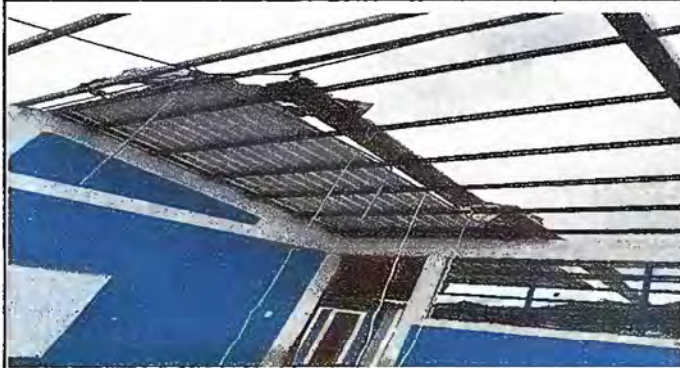
Foto1: Sustrución de lámina por lámina troquelada
