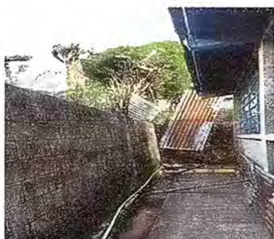
Foto 3: muro perimetral de block, con tubo HG, malla galvanizada, soleras intermedia y columnas
