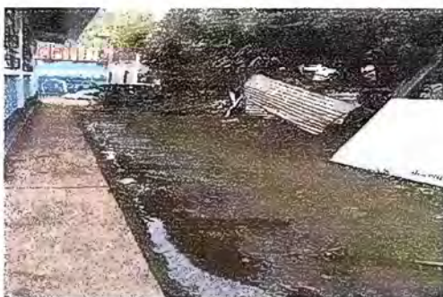
Foto 5: Reparacion de plancha de concreto de patio
