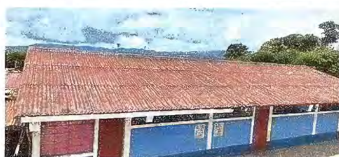
Foto 6: Sustrucion de canal de metal
