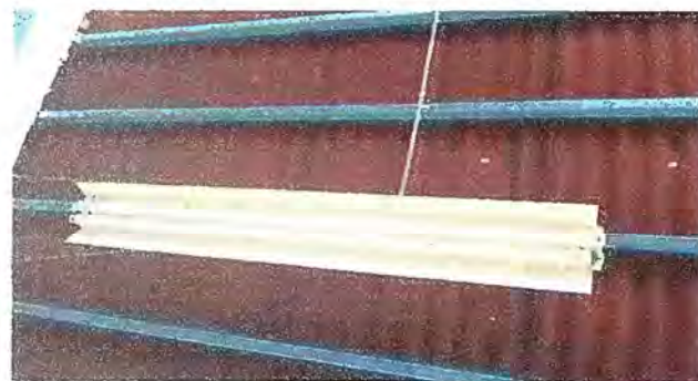
Foto 4: Sustrucion de plafoneras, cajas octagonales y bombillas
