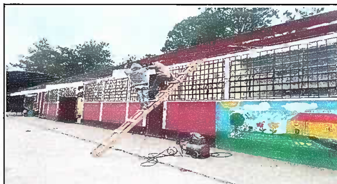
Módulo 3: Mantenimiento de estructura de soporte de metal en aulas 4, 5 y 6
