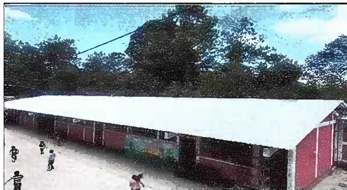
Módulo 3: Sustitución de capote de lámina por capote de lámina troquelada.
