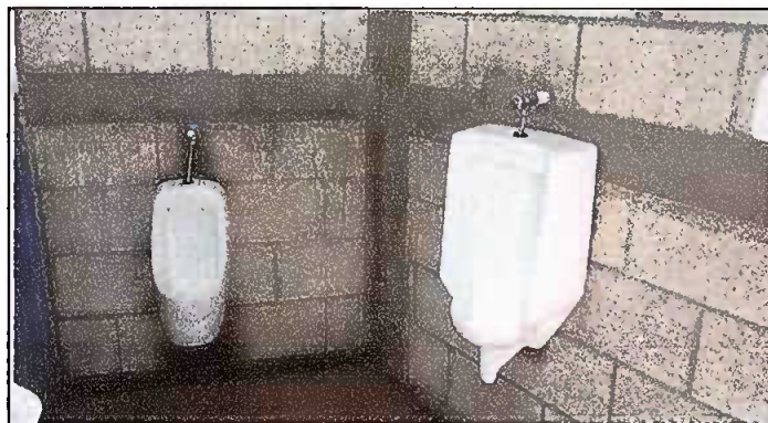
Foto 3: Modulo 5: Instalación de estructura mengitorios
