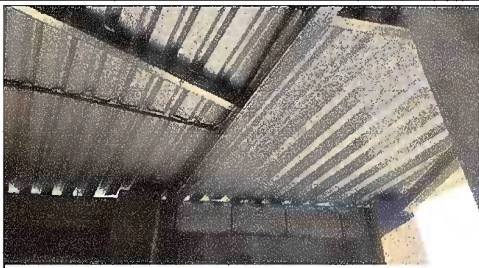
Foto 2: Modulo 5: Instalación de estructura portante de metal
