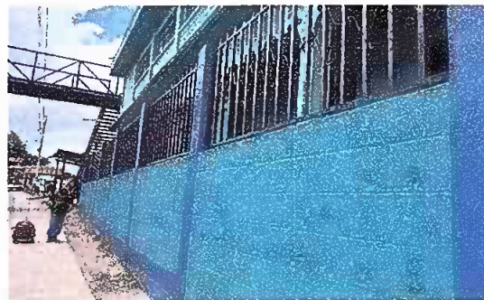
Foto 4: Pintura en muros interiores y exteriores
