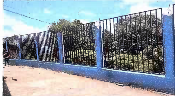
Foto 8: Mantenimiento de baranda de metal
