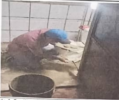
Foto 1: Módulo 1. Sustitución de inodoro
