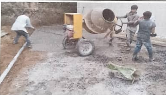
Foto 5: Módulo 2. Reparación de plancha de concreto de patio
