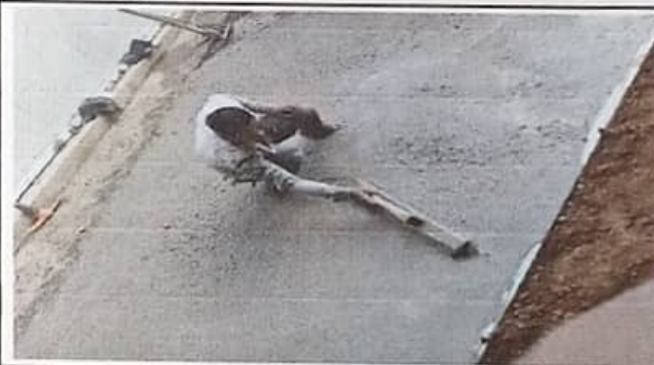
Foto 4: Módulo 2. Reparación de plancha de concreto de patio
