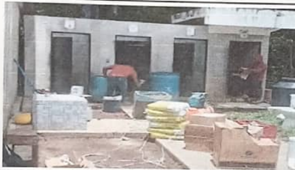
Foto 3: Módulo 1. Suministro e instalación de azulejo
