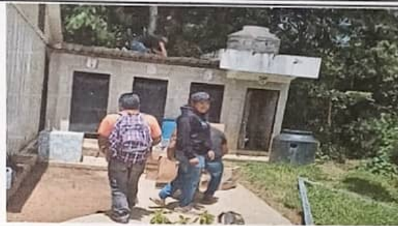
Foto 2: Módulo 1. Instalación de lámina
