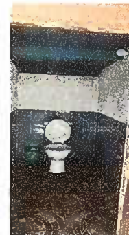
Foto 6: Módulo 3: Nuevo inodoro, instalación de piso e instalación de foco ahorrador.
