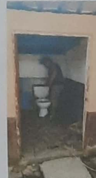
Foto 6: Módulo 3: Instalación de piso e inodoro.
