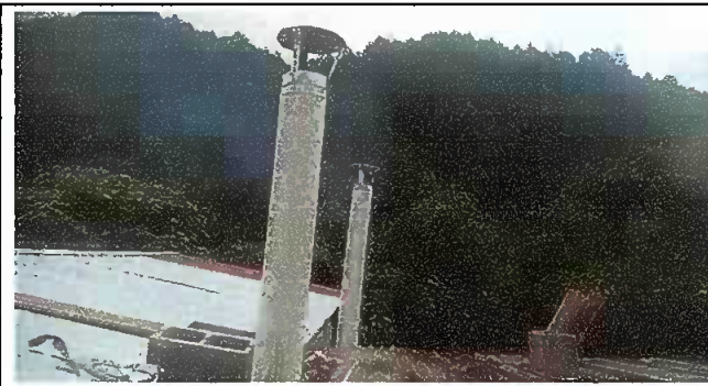
Foto 2: Módulo 2. Sustrucción de sombrero de chimenea de metal
