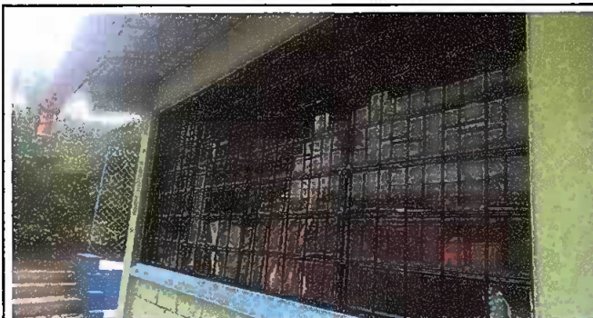
Foto 3: Módulo 1. Sumistro e instalación balcones de hierro de ventanas.
