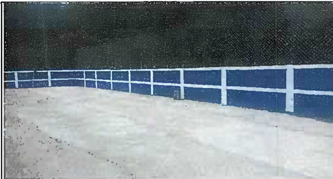
Foto 4: Muro perimetral: Reparación de muro perimetral de block con tubo HG y malla galvanizada soleras intermedias y columnas.
