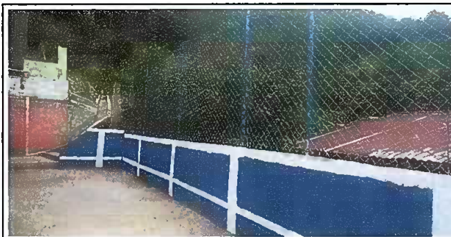
Foto 5: Muro perimetral: Reparación de muro perimetral de block con tubo HG y malla galvanizada soleras intermedias y columnas.
