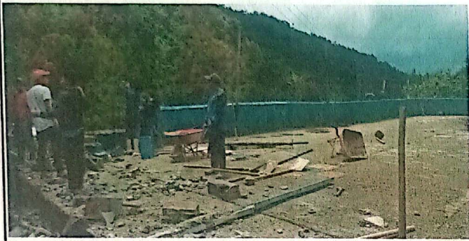
Foto 1: Muro perimetral: Reparación de muro perimetral de block con tubo HG y malla galvanizada soleras intermedias y columnas.
