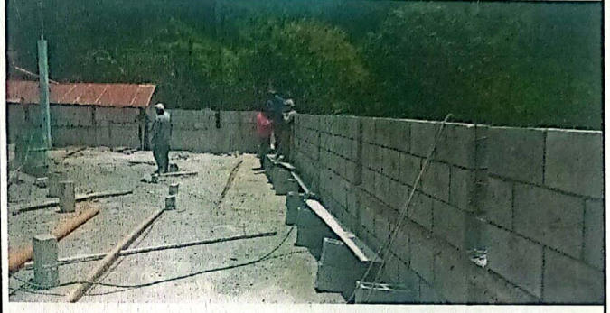
Foto 2: Muro perimetral: Reparación de muro perimetral de block con tubo HG y malla galvanizada soleras intermedias y columnas.
