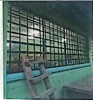
Foto 6: Módulo 1. Sumistro e instalación balcones de hierro de ventanas
