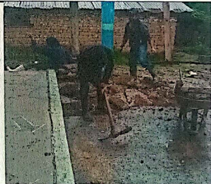
Foto 4: Cancha: Reparación de planchas de concreto patio
