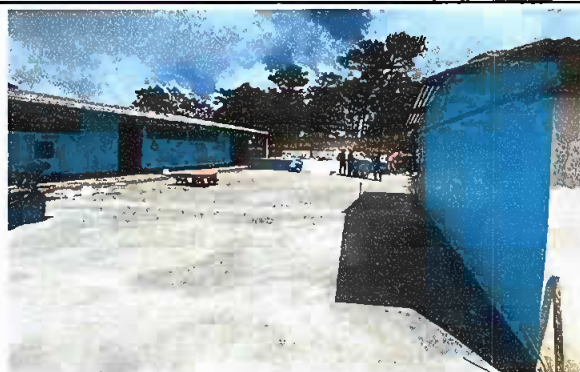
Foto 2: Sustitución de piso de torta de cemento.
