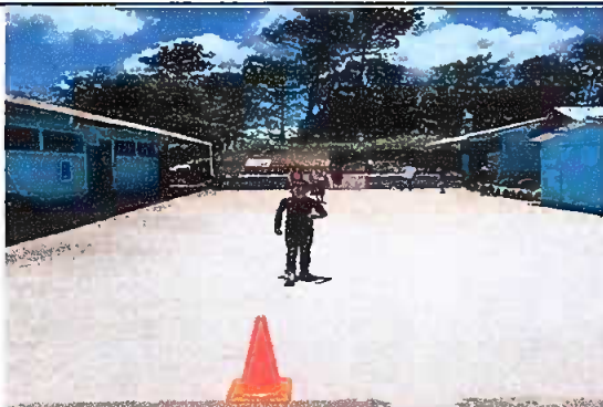
Foto 3: Sustitución de piso de torta de cemento.
