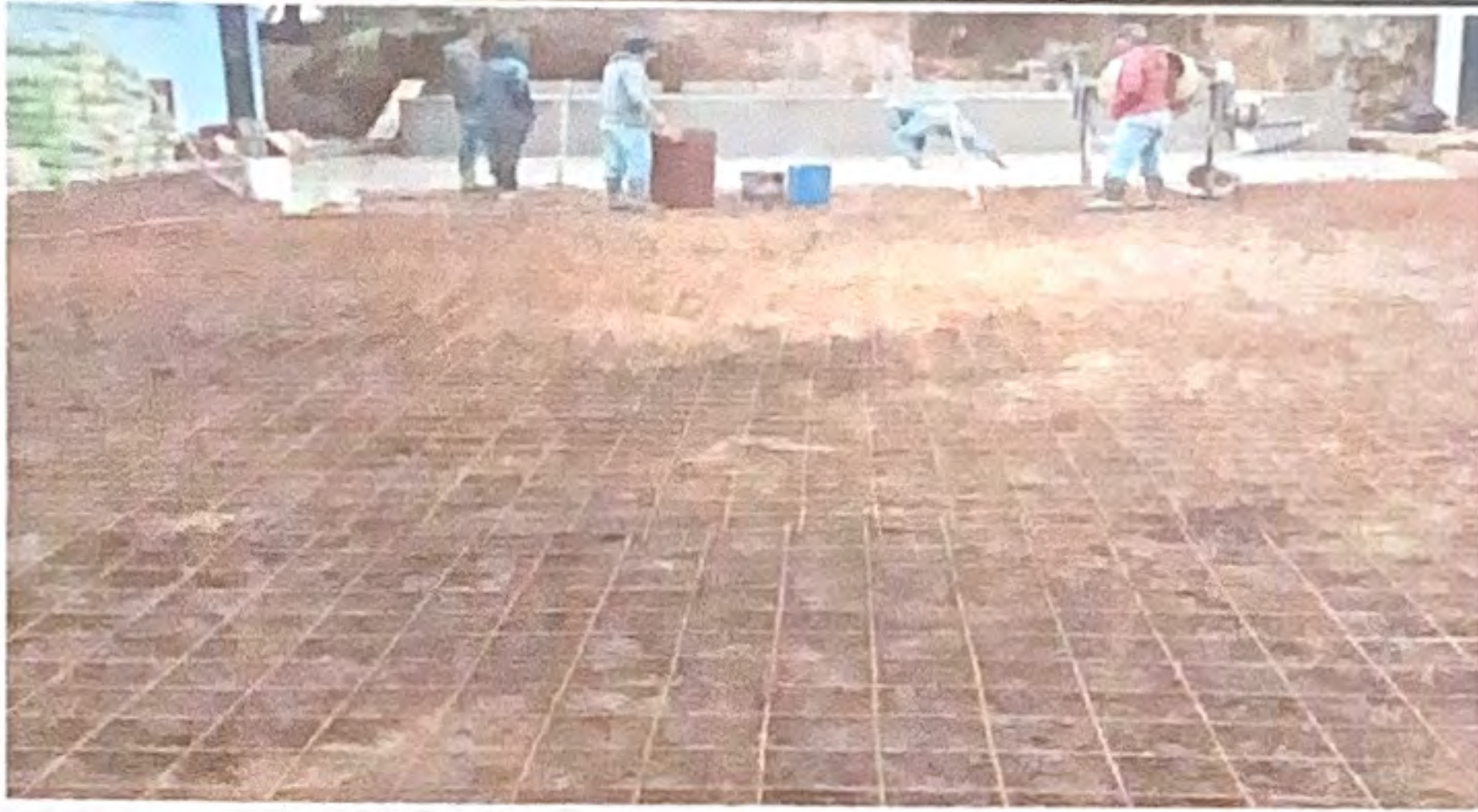
Foto1: Sustitución de piso de torta de cemento.
