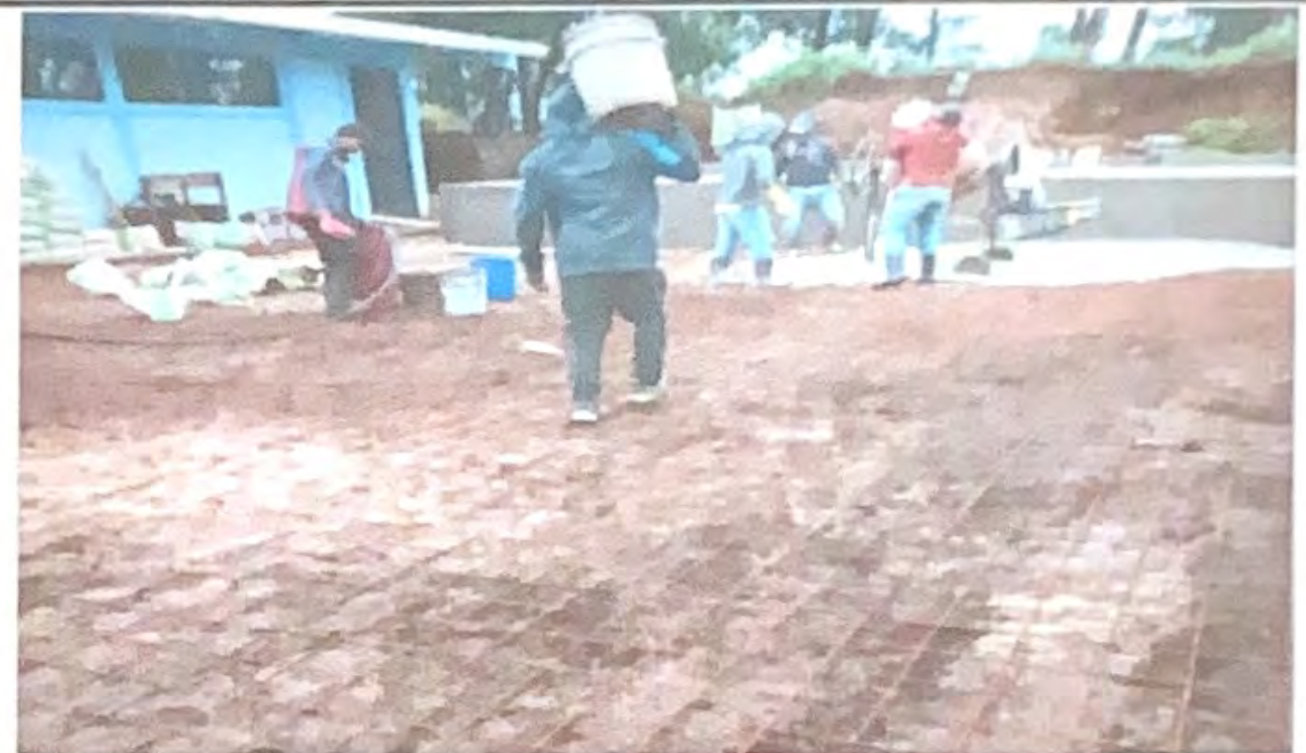
Foto 2: Sustitución de piso de torta de cemento.
