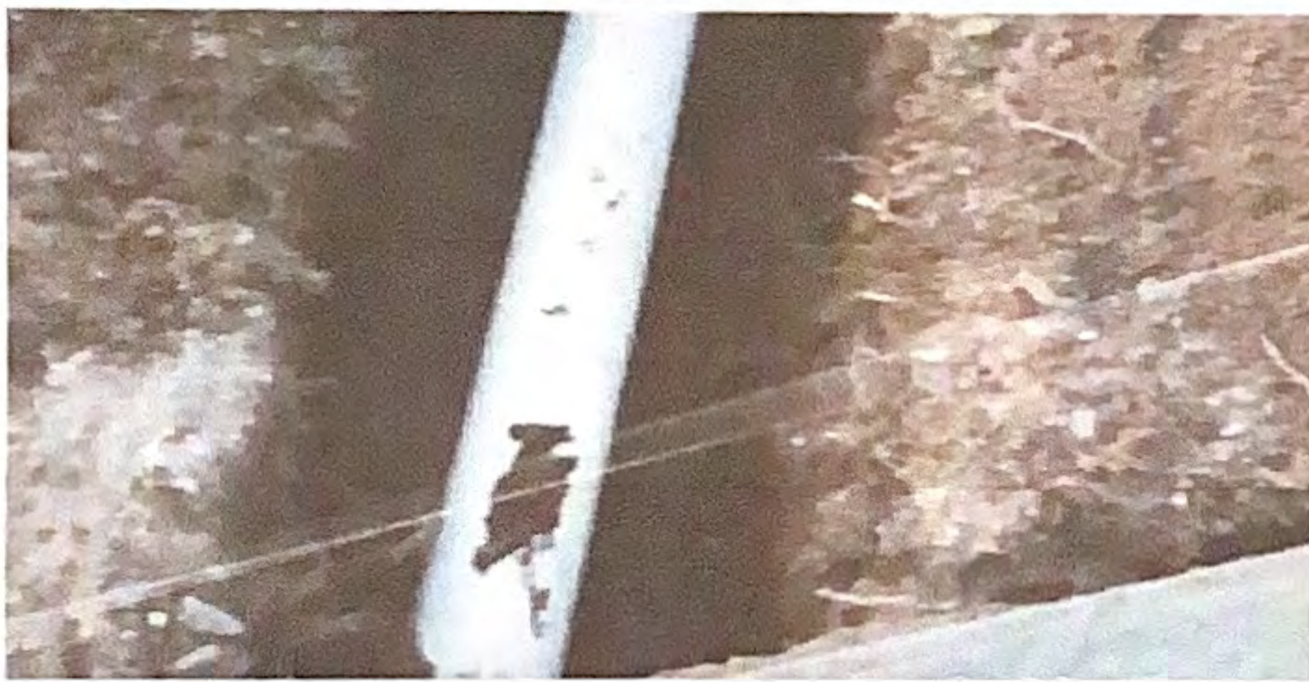
Foto 3: Sustitución de tubería PVC línea principal aguas pluviales .
