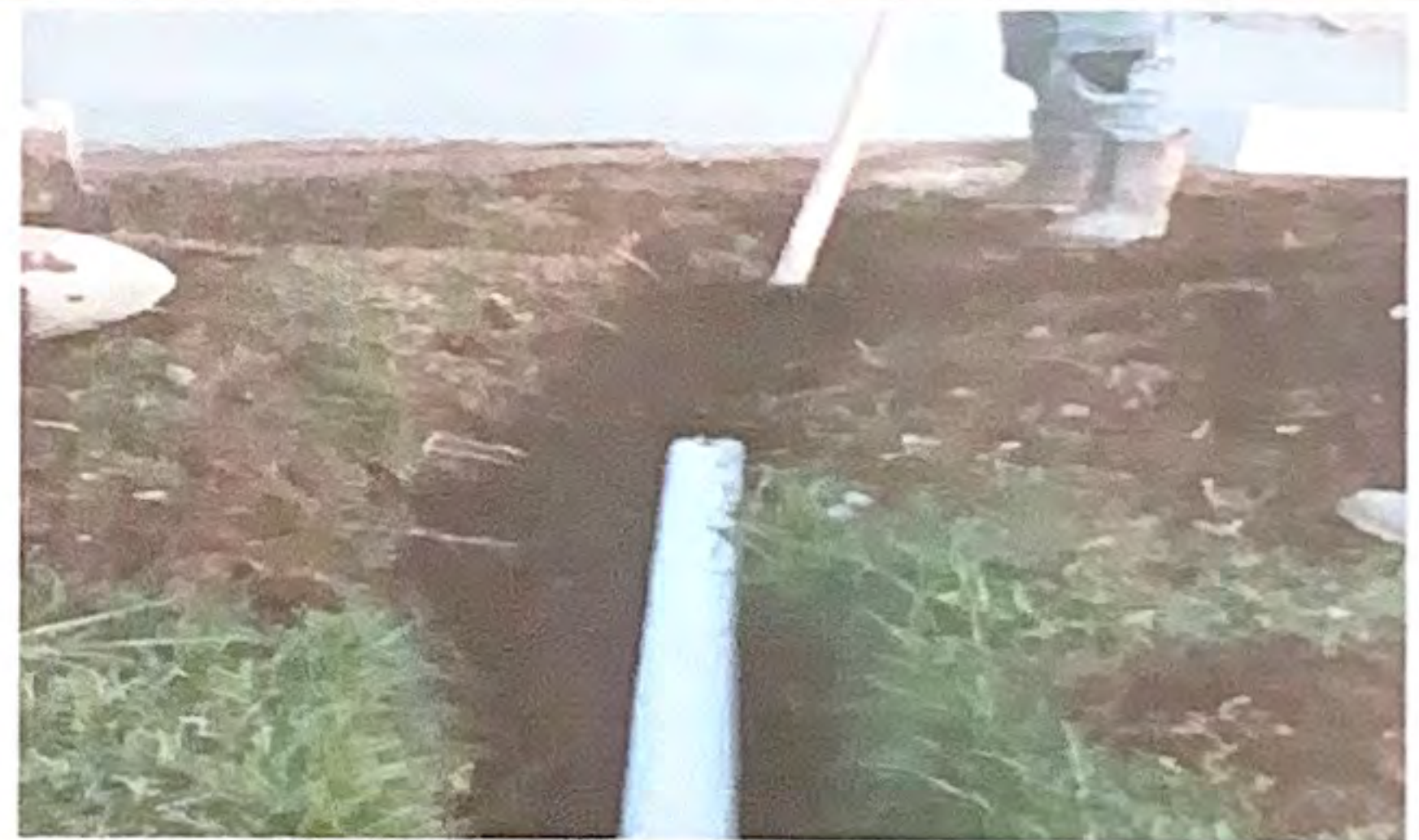
Foto 4: Sustitución de tubería PVC línea principal aguas pluviales .
