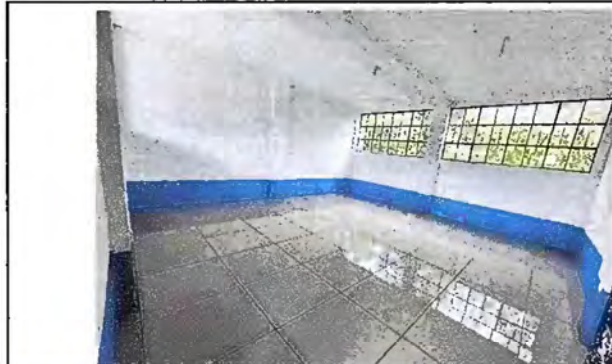
Foto 1: MODULO 1 Sustitución de piso de torta de concreto por piso cerámico
