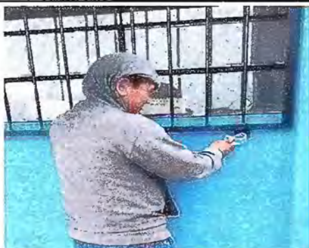
Foto 3: MODULO 2 Suministro e instalacion de balcones de metal
