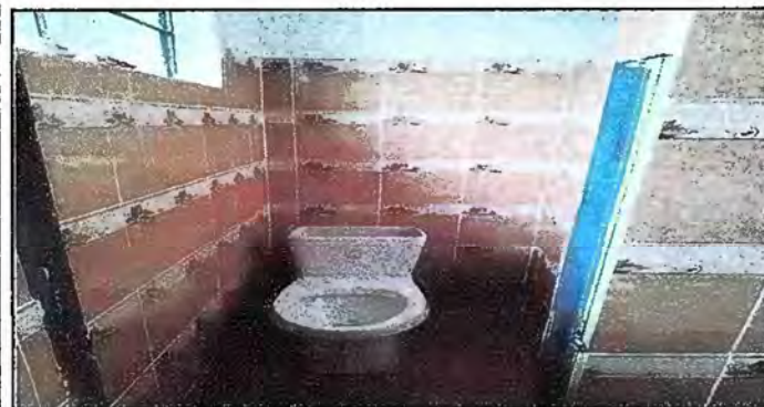
Foto 3 Servicio sanitario: Sustitución inodoro.
