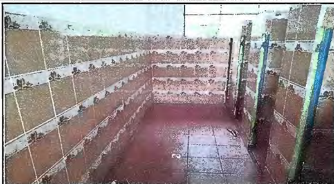
Foto 2 Servicios sanitarios: Suministro e instalación de azulejo.
