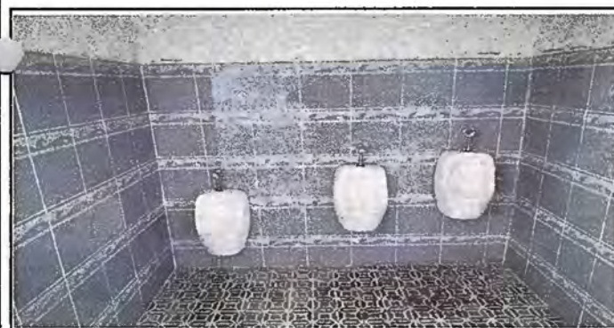
Foto 5 Servicios sanitarios : Sustitución de mingitorio
