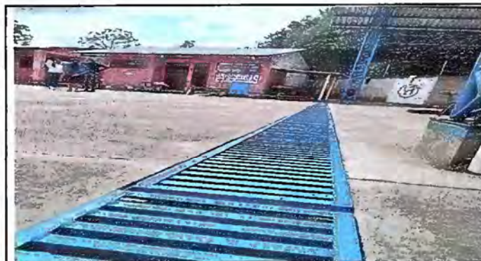
Foto 9 Patio : Reparación de cuneta de concreto
