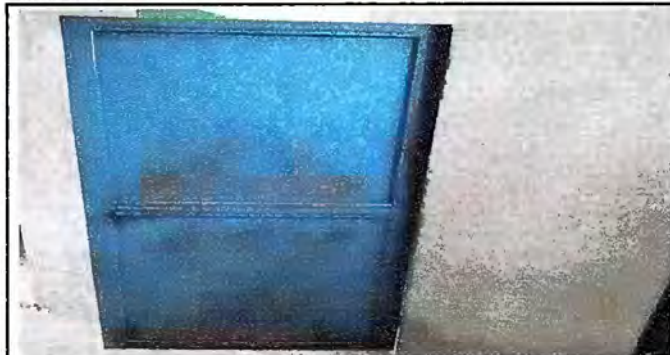
Foto 7 Servicios sanitarios: lijado y pintado de puertas metalicas .
