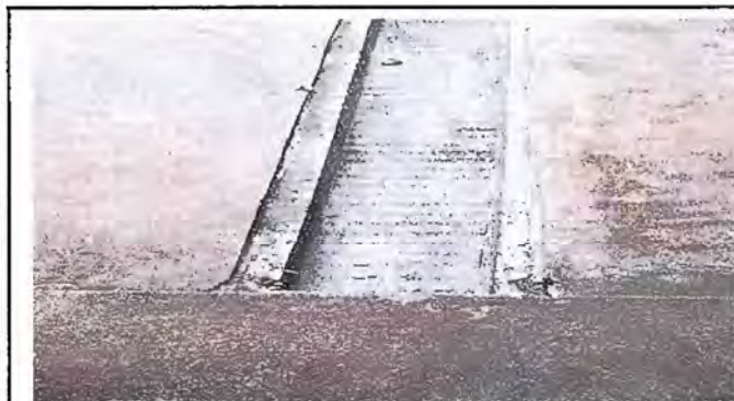
Foto 9 Patio : Reparación de cuneta de concreto
