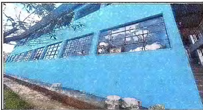
Foto 5, módulo 1: Pintura en muros exteriores e interiores
