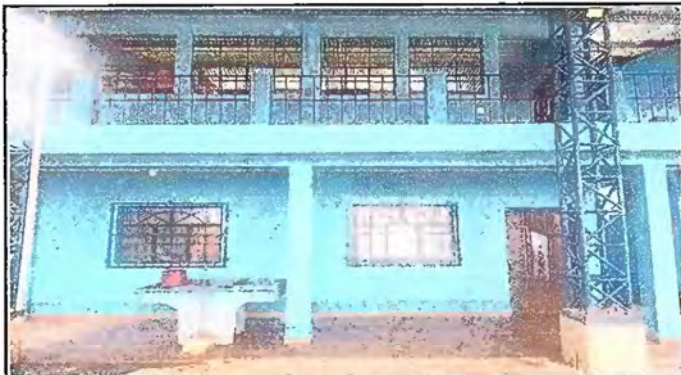
Foto 8, módulo 2: Pintura en muros exteriores e interiores
