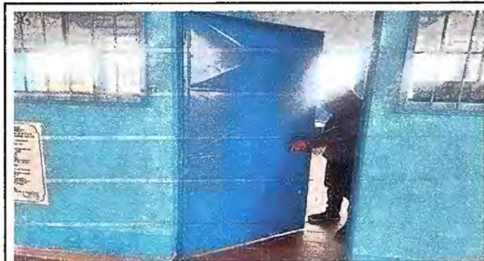
Foto 3, módulo 1: Sustitución de chapa
