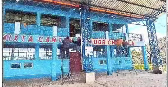
Foto 8, módulo 2: Pintura en muros exteriores e interiores.
