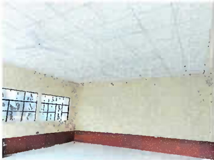
Módulo 1: Sustitución de cielo falso
