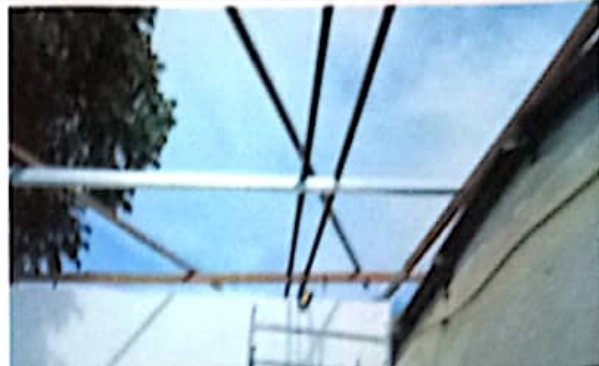
Módulo 1: Sustitución de lámina por lámina troquelada aluzin cal. 25
