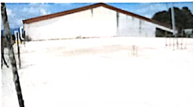
Módulo 2: Impermeabilización de losa.
