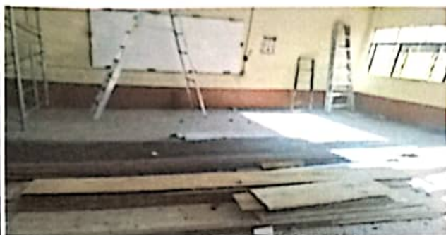
Módulo 1: Sustitución de cielo falso
