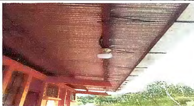
Foto 4: MODULO 2 Y 3 SUSTITUCION DE FOCOS AHORRADORES
