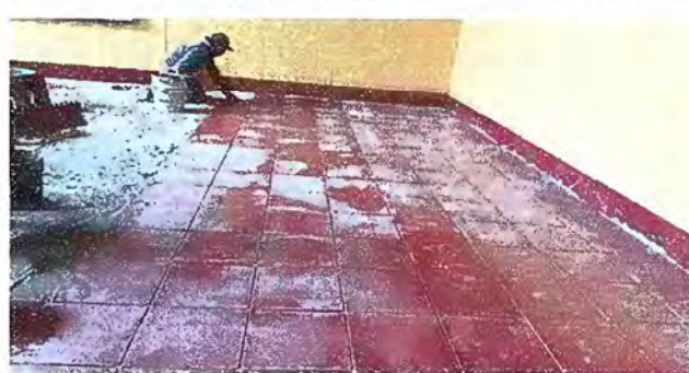
FOTO 6: MODULO 5 SUSTITUCION DE PISO CONCRETO POR PISO CERRAMICO
