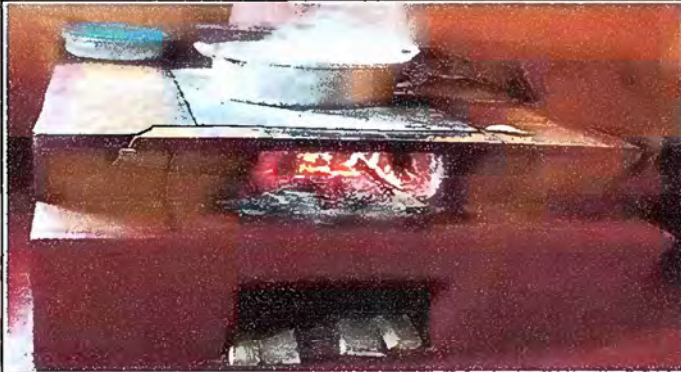
Foto 1: MODULO 2 SUSTITUCIÓN DE ESTUFA RURAL (COMPLETA) INCLUYE CHIMENEA Y PLANCHA DE METAL
