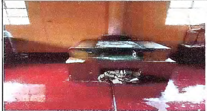
Foto 2: MODULO 2 SUSTITUCIÓN DE ESTUFA RURAL (COMPLETA) INCLUYE CHIMENEA Y PLANCHA DE METAL
