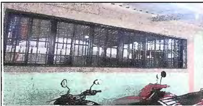
Foto 5: Módulo 1. Levantado de muro y sustitución de ventana de metal con balcón
