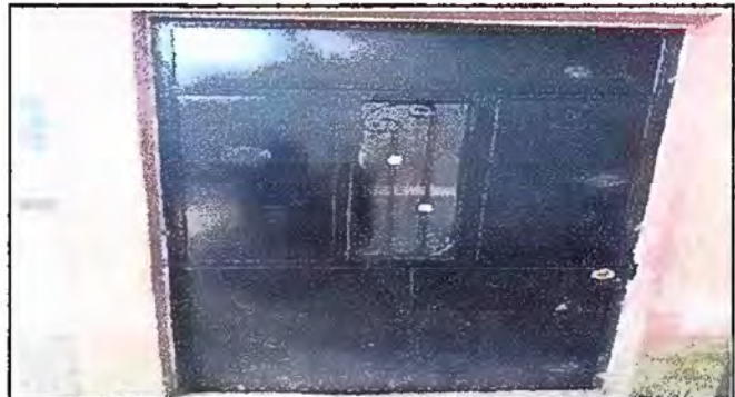
Foto 10: Módulo 2. Sustitución de puerta de metal.
