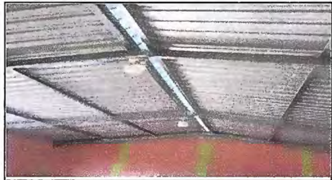
Foto 8: Módulo 2. Sustitución de estructura metálica.
