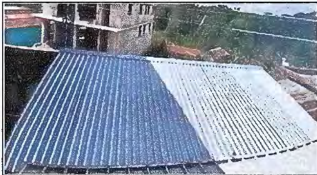
Foto7: Módulo 2. Sustitución de lámina troquelada.
