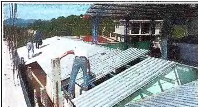
Foto 8: Módulo 1. Colocación de lamina troquelada.
