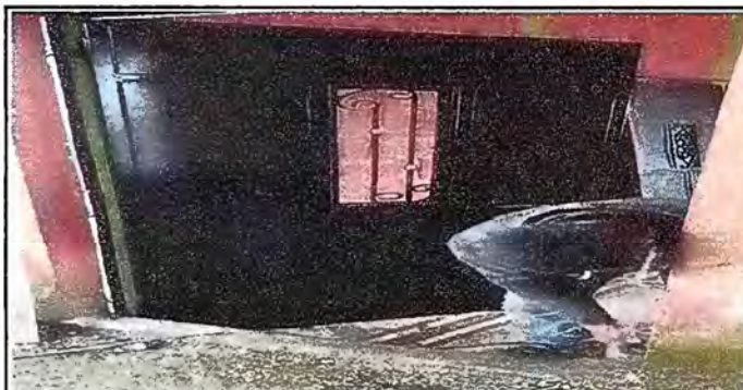
Foto 10: Módulo 2. colocación de puerta de metal.
