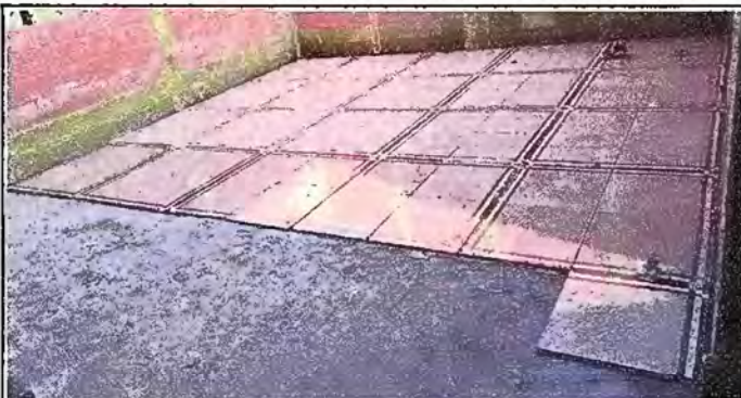
Foto7: Módulo 2. colocación de piso ceramico en el modulo 2.
