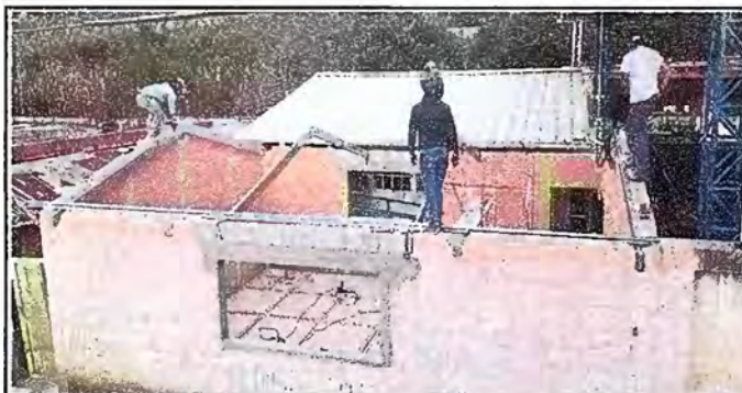
Foto 6: Módulo 2. Durante el proceso se está haciendo la colocación de tubo estructural galvanizado.
