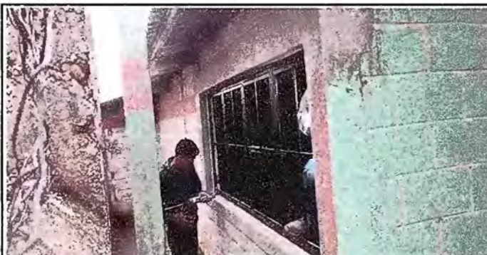
Foto 9: Módulo 1. colocación de ventana de metal.
