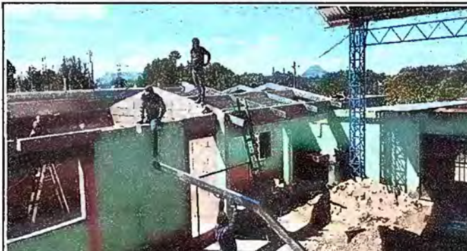
Foto 2: Módulo 1. Durante el proceso se está haciendo la colocación de tubo estructural galvanizado.
