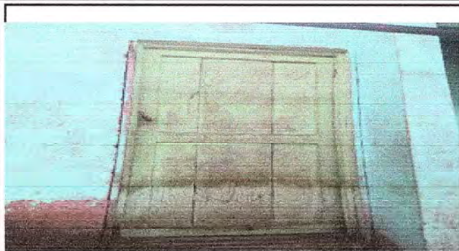
Foto 7: Sustrucción de puertas de madera por metal
