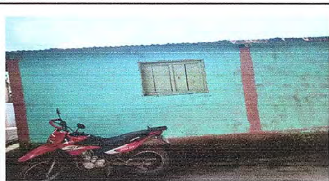
Foto 8: MODULO 1 Sustrucción de ventanas de metal
