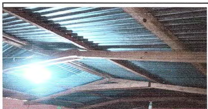
Foto 11: MODULO 2 Sustrucción de estructura de soporte de madera por metal
