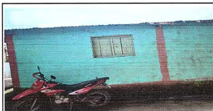
Foto 5: MODULO 1 Reparación de muro de block
