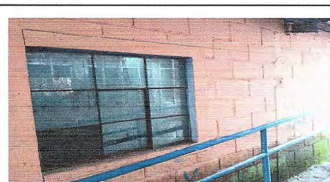
Foto 10: MODULO 2 Reparación de muro de block
