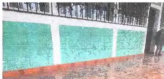
Foto 2: (MODULO 1). Se ha terminado la colocación de los zócalos en las tres aulas y corredor.
