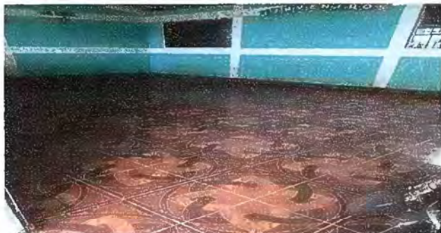
Foto 1: (MODULO 1). Uno de los salones ya esta terminado la colocación de pisos cerámico.
