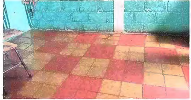
Foto 2: (MODULO 1). Los pisos en malas condiciones necesita sustitución.
