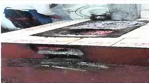
Foto 5: (MODULO 2). vista de la plancha, actualmente se encuentra en malas condiciones, se necesita sustitución de plancha.
