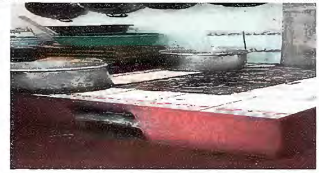
Foto 6: (MODULO 2). se observa las malas condiciones de la plancha, por el tiempo de vida de los materiales, se necesita sustitución de estufa rural.
