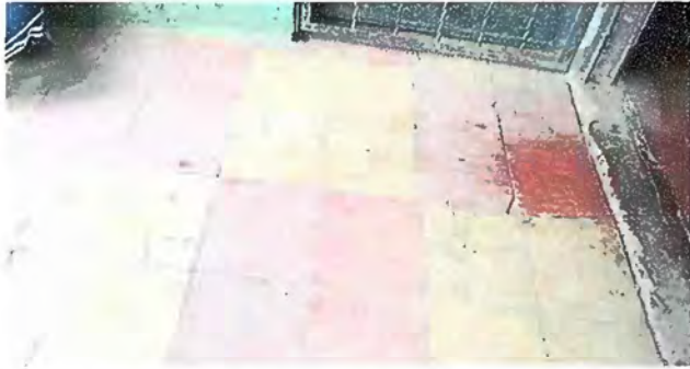
Foto 1: (MODULO 1). Estado actual de los pisos de los salones de clase en malas condiciones, se necesita sustitución de piso.
