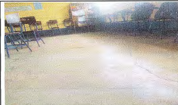
Foto 10: MODULO 3: Sustitución de piso de torta de concreto por piso ceramico
