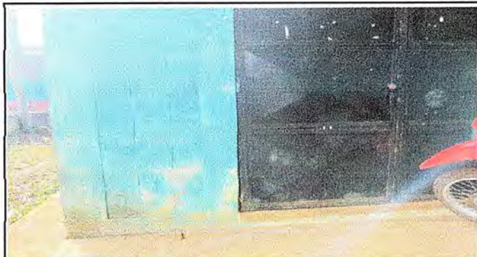
Foto 7: PUERTA GENERAL: Mantenimiento a estructura de puerta (lijado, Cepillado Aplicación de pintura)
