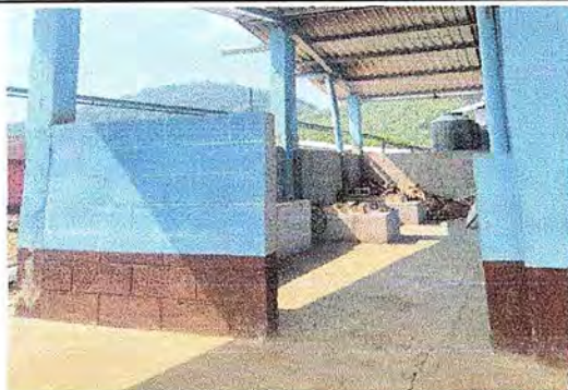
Foto 3: MODULO 1 Sustitución de Puerta
