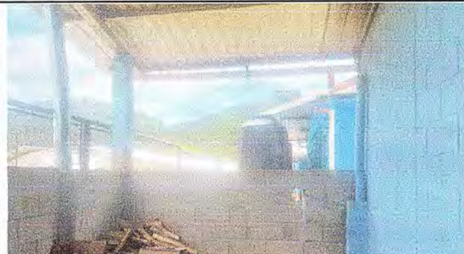
Foto 2: MODULO 1 Reparación de muro de block
