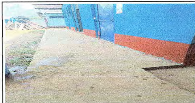
Foto 9: MODULO 2: sustitución de piso de torta de concreto por piso ceramico antideslizante.
