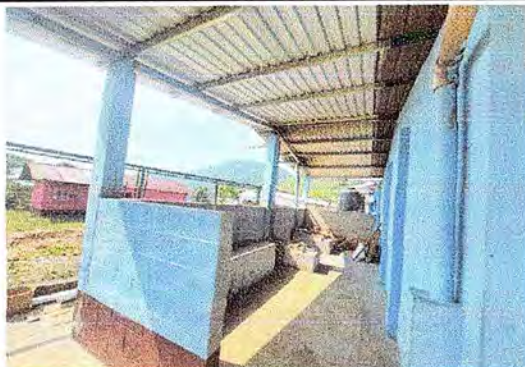
Foto 1: MODULO 1 Suministro e instalación de ventanas tipo rejilla
