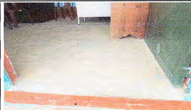
Foto 8: MODULO 2: Sustitución de piso de torta de concreto por piso ceramico
