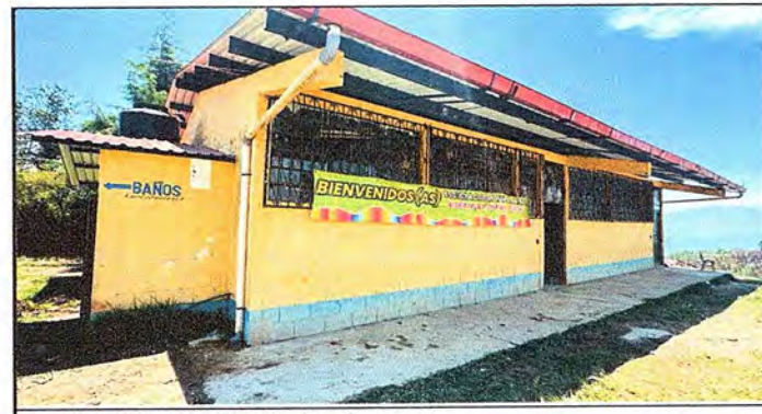
Foto 6: MODULO 5. Sustitucion de puertas
