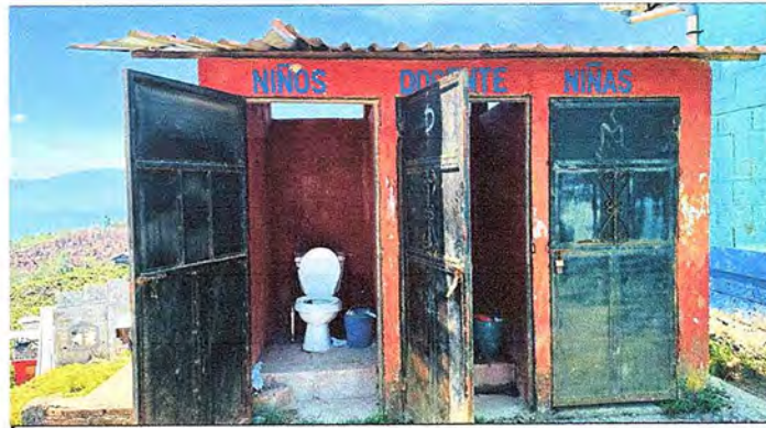
Foto 4: MODULO 4. Sustitucion de inodoro de inodoro, sustitucion de puertas y sustitucion de lamina, por lamina troquelada.
