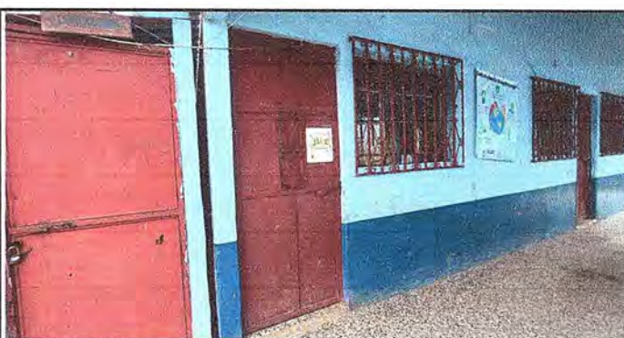
Foto 6 MODULO 2: MANTENIMIENTO DE ESTRUCTURA DE PUERTA
