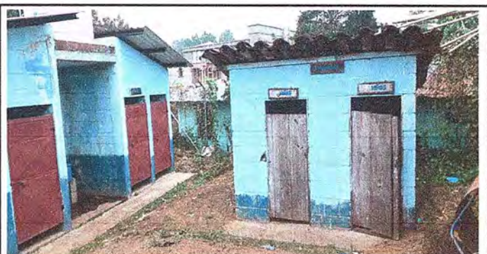
Foto 12 MODULO 4: SUSTITUCIÓN DE PUERTA
