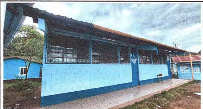
Foto 10 MODULO 3: SUSTITUCIÓN DE CANAL PVC
