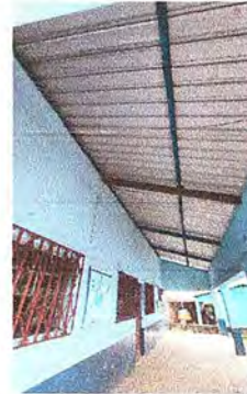
Foto 8 MODULO 2: SUSTITUCIÓN DE FOCOS
