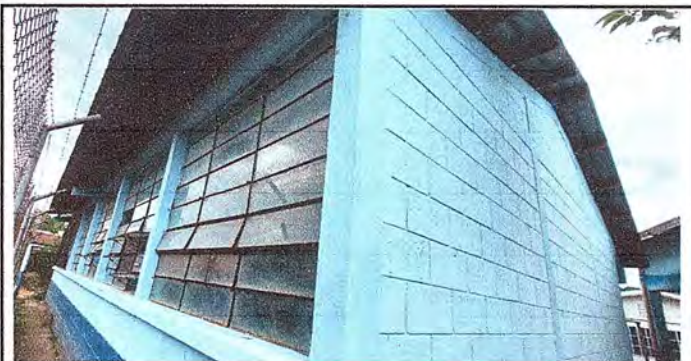
Foto 11 MODULO 3: SUMINISTRO E INSTALACIÓN DE BALCON DE HIERRO EN VENTANA
