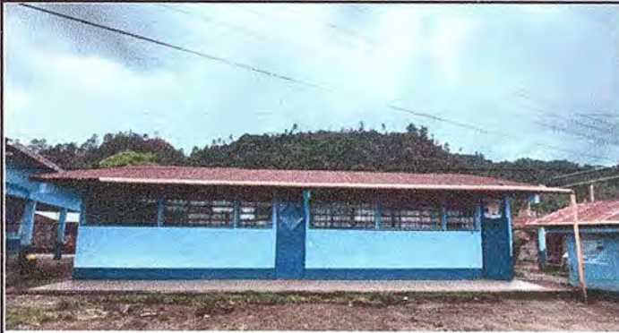
Foto 9 MODULO 3: SUSTITUCIÓN DE LAMINAS, POR LAMINA TROQUELADA ALUZINC CALIBRE 26
