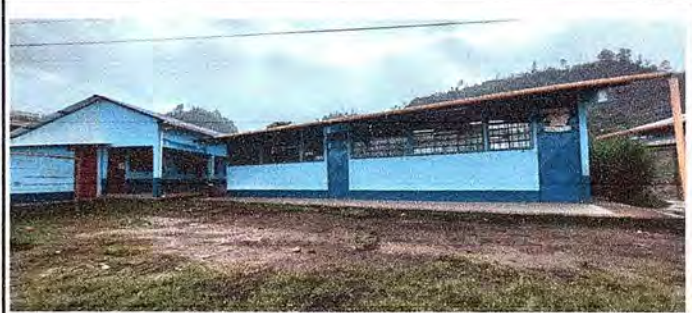
Foto 14 MODULO 4: PINTURA EN MUROS EXTERIORES E INTERIORES
