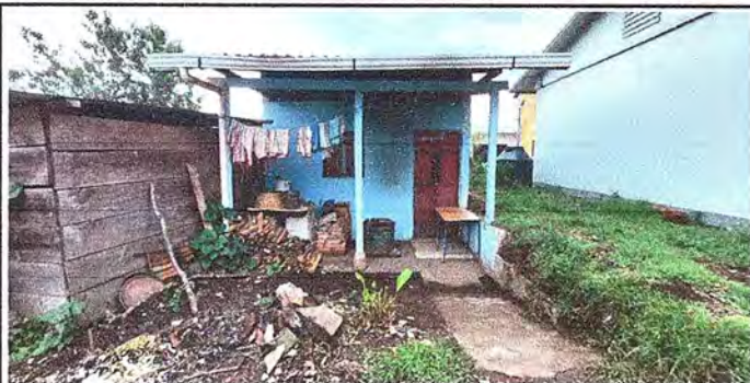
Foto 2 MODULO 1: SUMINISTRO E INSTALACION DE ESTRUCTURA PORTANTE Y DE SOPORTE DE METAL
