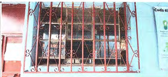
Foto 5 MODULO 2: MANTENIMIENTO A ESTRUCTURA DE VENTANA
