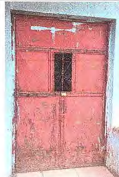
Foto 4 MODULO 1: MANTENIMIENTO A ESTRUCTURA DE PUERTAS
