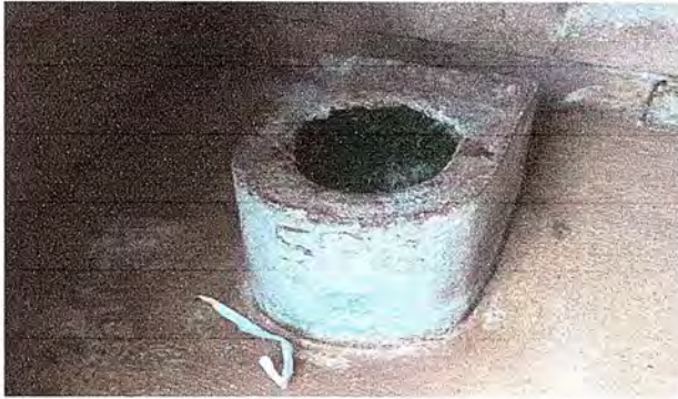
Foto 13 MODULO 4: SUSTITUCIÓN DE INODORO
