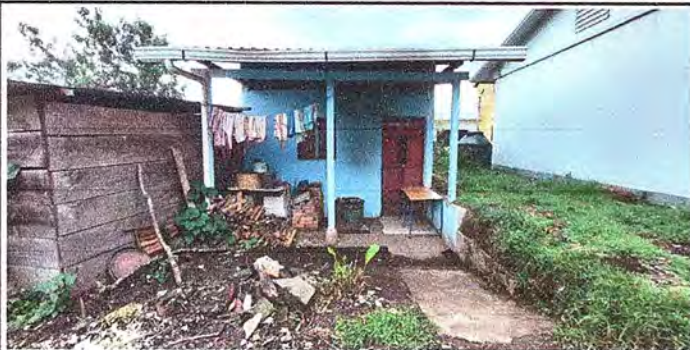
Foto 1 MODULO 1: SUMINISTRO E INSTALACION DE LAMINAS TROQUELADAS CALIBRE 26
