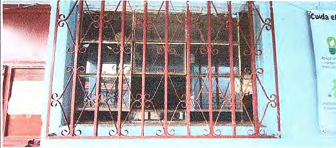
Foto 7 MODULO 2: MANTENIMIENTO A BALCONES DE METAL
