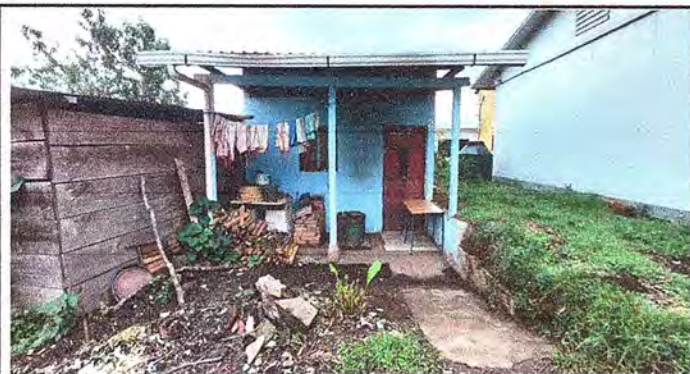
Foto 3 MODULO 1: REPARACIÓN DE PISO DE CONCRETO
