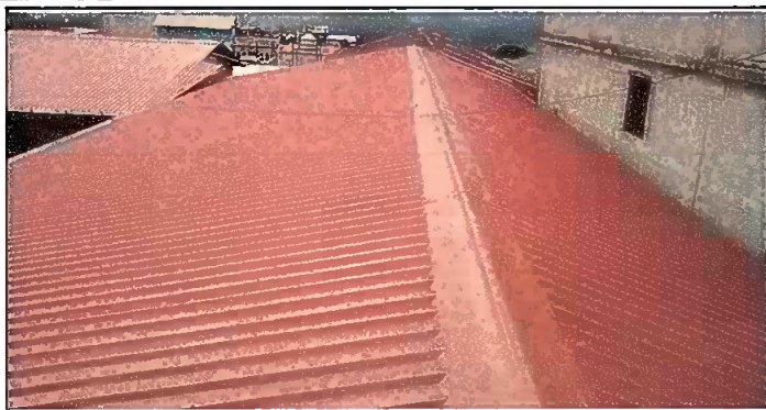
Foto1: Instalción de láminas Troqueladas calibre 26 +capotes +elementos de fijación. Se logró la instalción de 220.71 M2
