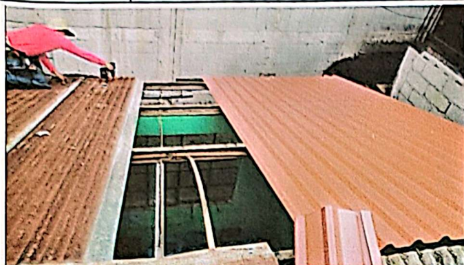
Foto1: Se inicia los trabajos de desinstalación e Instalación de láminas Troqueladas calibre 26 +capotes +elementos de fijación.
