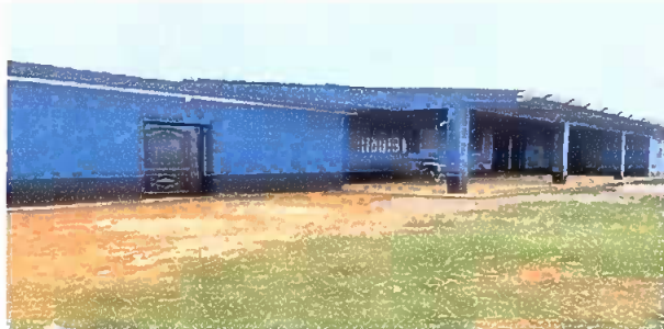
Foto1: PINTURA EN MUROS EXTERIORES E INTERIORES
