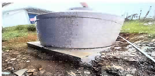
Foto 5: SUMINISTRO DE TINACO
