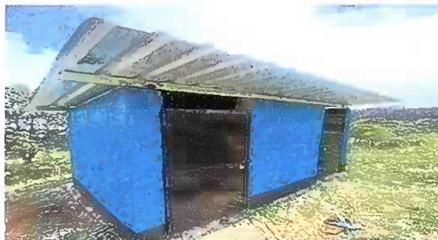
Foto 6: INSTALACION DE TECHO Y PUERTAS
