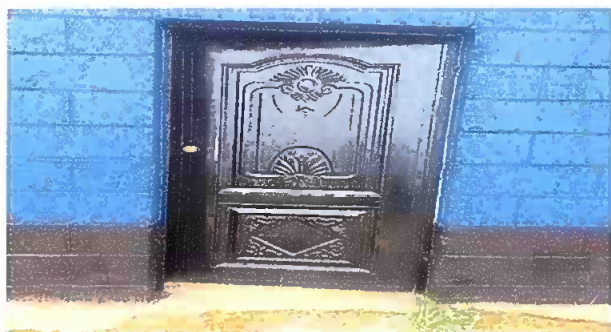
Foto 3: INSTALACION DE PUERTA
