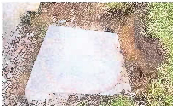
Foto 4: BASE DE CONCRETO PARA TINACO
