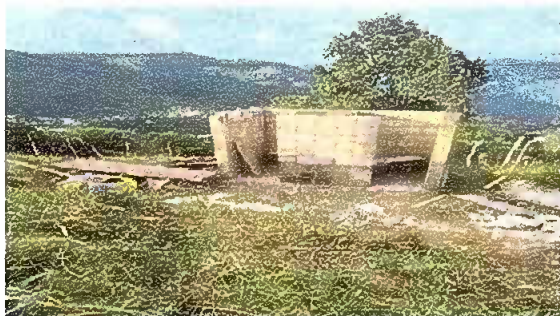
Foto 1: REPARACIONES EN SANITARIOS
