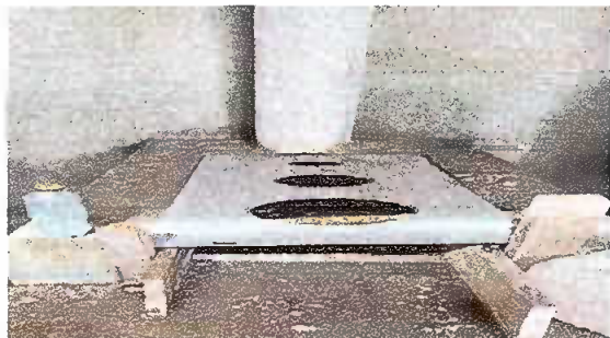
Foto 5: INSTALACION DE PLANCHA DE METAL DE TRES ORNILLAS
