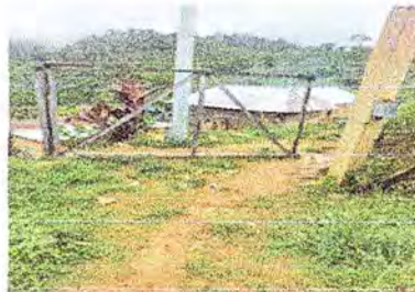
FOTO 8 AREAS EXTERIORES: SUSTITUCION DE PORTON
