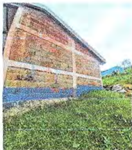
FOTO 1 MODULO I: REPELLO DE MURO Y SUSTITUCION DE LAMINA
