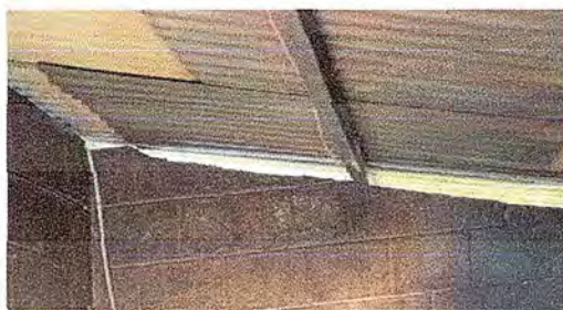
FOTO 5 MODULO II. SUSTITUCION DE ESTRUCTURA PORTANTE DE MADERA POR METAL
