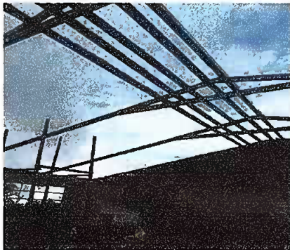
Foto 5: MODULO 2, SUSTITUCIÓN DE ESTRUCTURA CON ESTRUCTURA METÁLICA.
