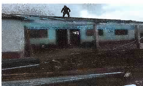
Foto 6: MODULO 2, SUSTITUCIÓN DE ESTRUCTURA CON ESTRUCTURA METÁLICA.
