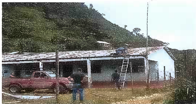
Foto 3: MODULO 2, SUSTITUCIÓN DE LÁMINA.
