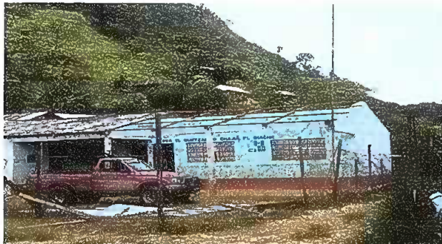
Foto 1: MODULO 1, SUSTITUCIÓN DE ESTRUCTURA CON ESTRUCTURA METÁLICA.
