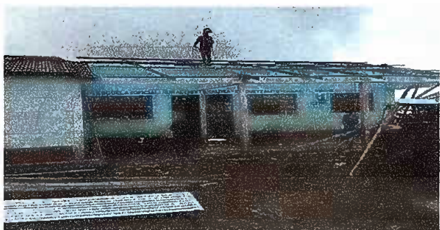
Foto 5: MODULO 2, SUSTITUCIÓN DE ESTRUCTURA CON ESTRUCTURA METÁLICA.
